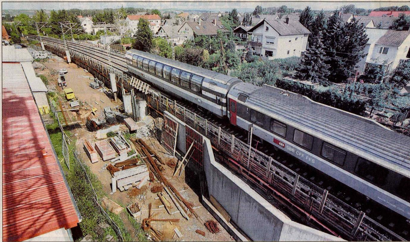
Ein neuer Bahn-Haltepunkt wird derzeit mitten in der Gemeinde Nackenheim gebaut. Anbindungen sind über den Lindenweg und die Straße Im Brühl möglich. Auf dem Baustellenfoto zu sehen sind der mit Stahl und Holz stabilisierte Bahndamm sowie ein Teil der Betonstützwände. Zwischen Gleis und neuer Mauer werden dann auf beiden Seiten die Bahnsteige angelegt. Foto: hzb/Michael Bahr
